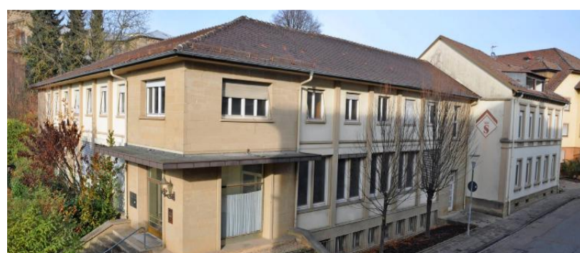
Im Gebäude der alten Sparkasse soll die Forstverwaltung in einigen Jahren ihre endgültige Heimat finden. Rechts daneben die Interimsunterkunft. Foto: Archiv/Hettich
